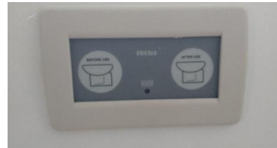
Commandes de la chasse d'eau
